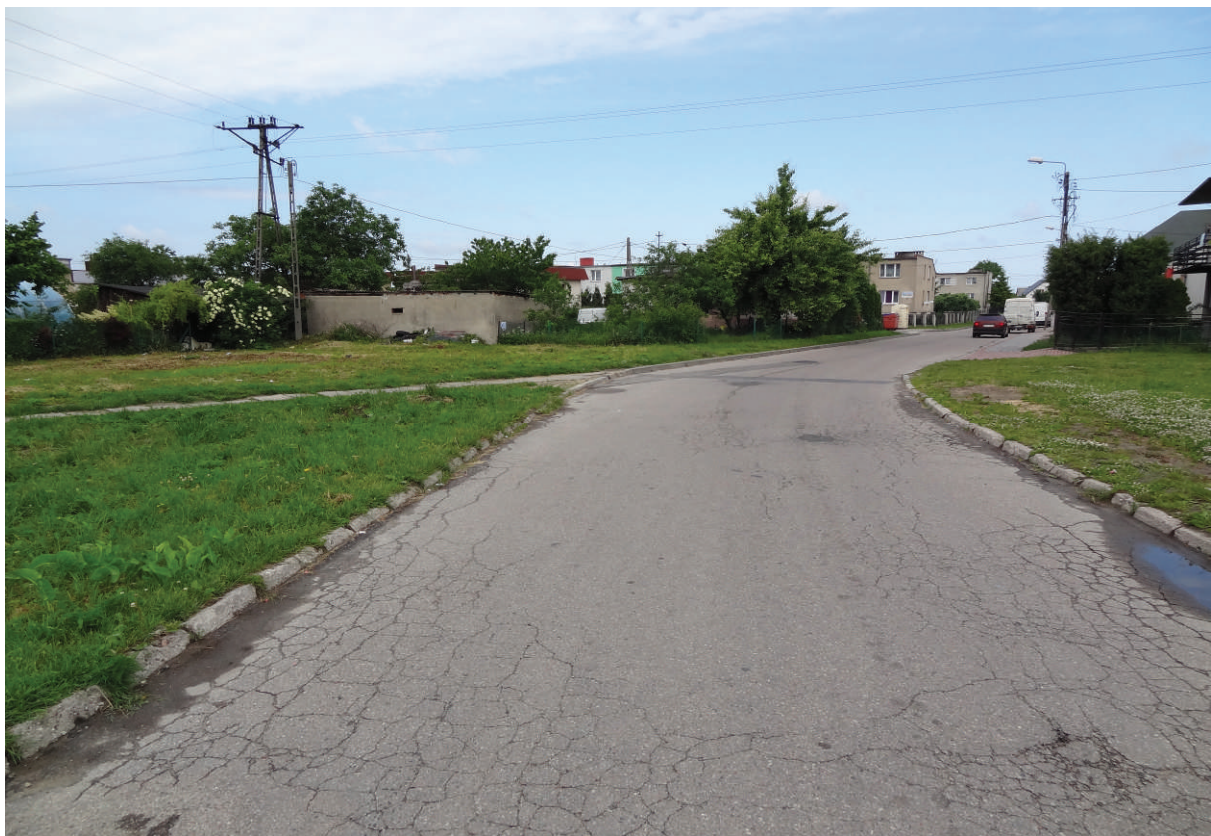
Fot. 5. Ul. Polna w km 0+225.
