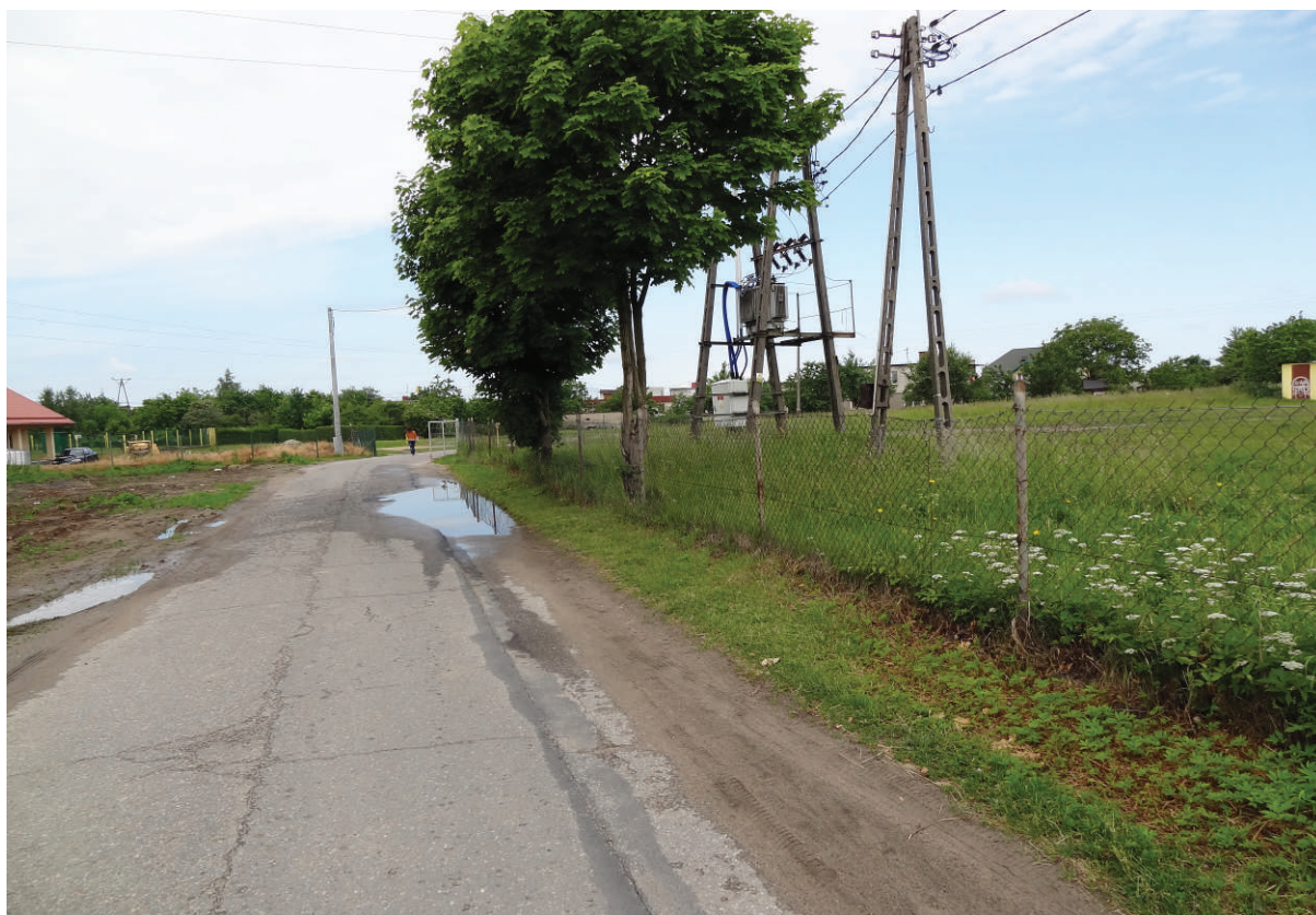
Fot. 3. Ul. Polna w km 0+125.
