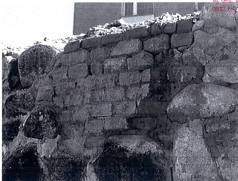
Fot. nr 9. Wtórne wypełnienie ubytków w licu muru poprzez zamurowanie cegłą ceramiczną. Widoczny zły stan spoin zarówno pomiędzy kamieniami jak i cegłami.
