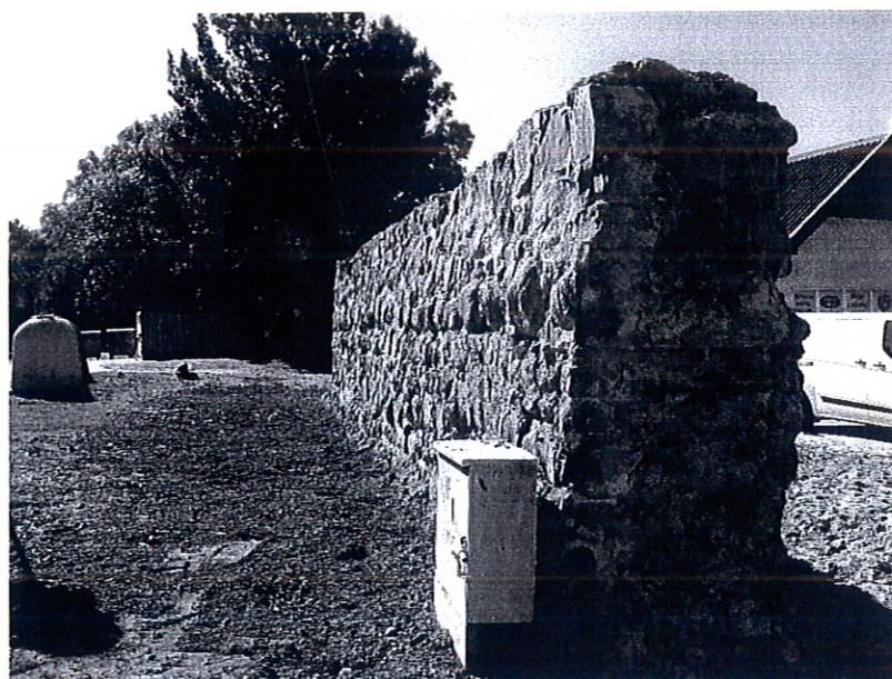
Fot. nr 2. Widok muru od strony północnej. Widoczna skrzynka przyłączeniowa sieci elektrycznej nieistniejącego już budynku.
