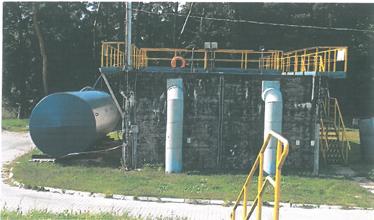
Zdjęcie 4-1 Komory defosfatacji z prowizorycznym zbiornikiem buforowym na ścieki przemysłowe dowożone (po lewej stronie komór).
