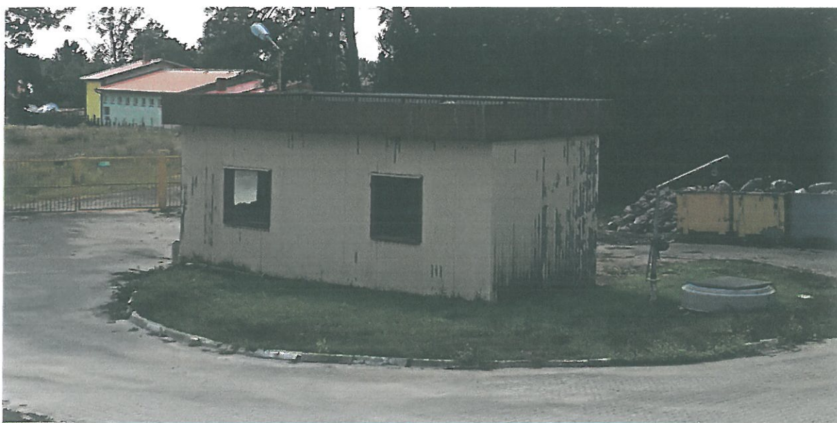
Zdjęcie 4-2 Stacja zlewna ścieków dowożonych
