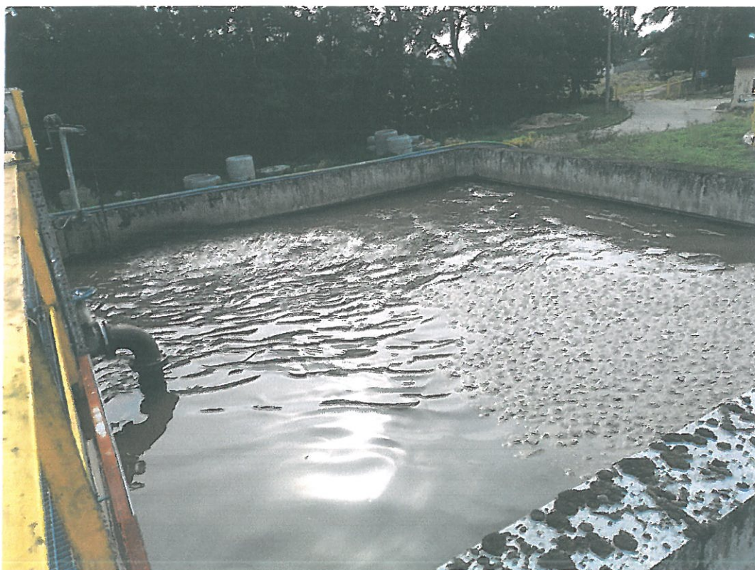
Zdjęcie 4-4 Komora denitryfikacji. Na pierwszym planie widoczne wyraźne porosty.
