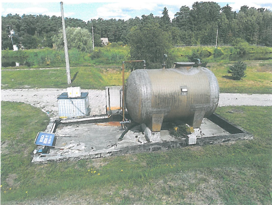
Zdjęcie 4-6 Stacja dozowania koagulantu.
